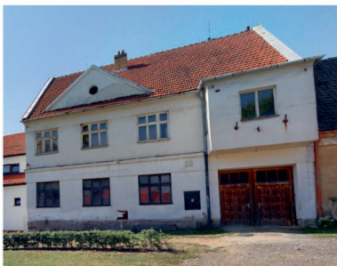
Původní stav budovy před demolicí
